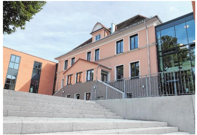
Das jüngste Pflegeheim in und bei der alten Dorfschule in Rommelsbach ist eine gelungene Sache.
