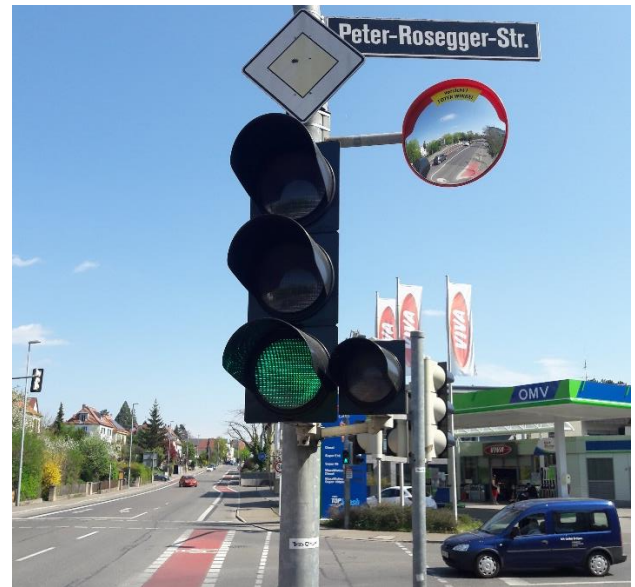
Der Trixi-Spiegel ermöglicht dem LKW-Fahrer einen Blick in den toten Winkel.
