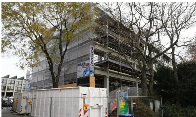
Das Bild von Ralph Bausinger aus den Reutlinger Nachrichten zeigt den Rathaus-Teil am Oskar-Kalbfell-Platz, der derzeit die Hauptbaustelle der Sanierung ist.
