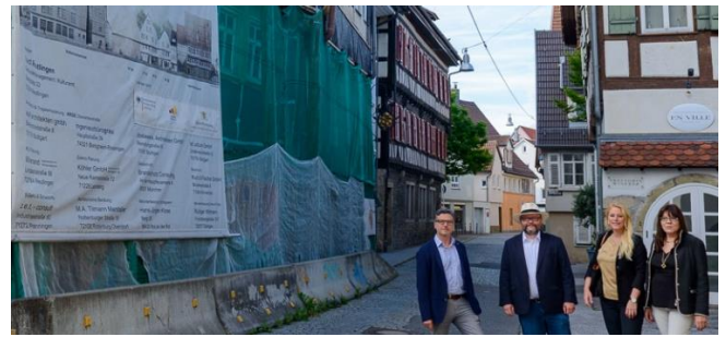
Die Stadträtinnen Regine Vohrer und Sarah Zickler mit MdL Dr. Christian Jung und LIM-Chef Thilo Scholpp (links) vor der historischen Häuserzeile an der Oberamteistraße
