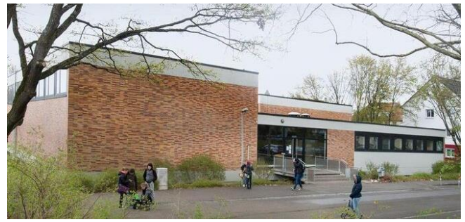
Der Sportbau (hier ein GEA-Foto von Gerline Trinkhaus) der Eduard-Spranger-Gemeinschaftsschule wird in drei Bauabschnitten saniert.
