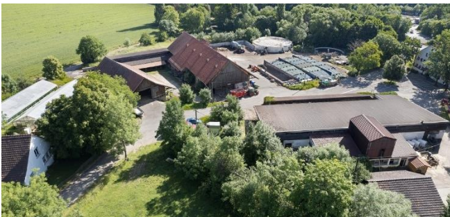
Die Wirtschaftsgebäude des Hofguts Alteburg sind teilweise marode und müssen vom neuen Pächter erneuert werden.
