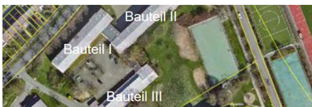
Wo jetzt der Bauteil III der Römerschanzschule ist, entsteht künftig der Neubau.
