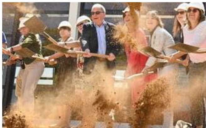
Beim Spatenstich für die Erweiterung der Mensa und weitere Betreuungsräume in der Rommelsbacher Grundschule am Raisweg wirkte auch Regine Vohrer (Zweite von links) kräftig mit, wie das Pieth-Foto aus dem GEA zeigt.
