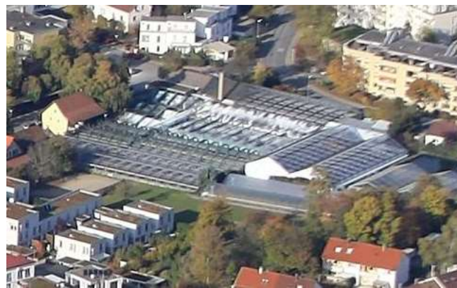
Jetzt ist der Knopf dran: Auf dem Gelände der ehemaligen Gärtnerei Bihler werden Wohnungen gebaut.
